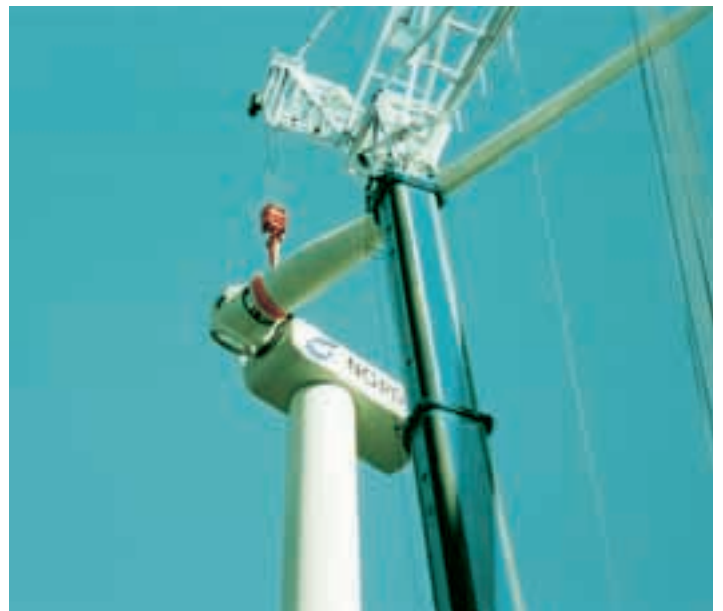
... für die Installation an der Gondel
