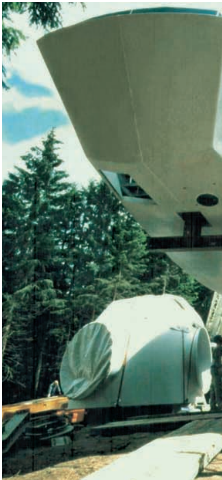
Errichtung einer S77/1500 kW
