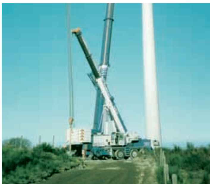
Errichtung des Rohrturms mit einer Höhe von 46 Meter.
