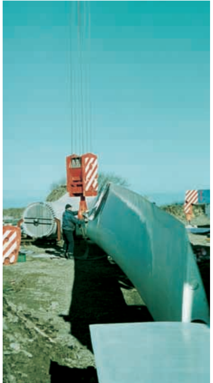
Eines der drei 29m langen und 5t schweren Rotorblätter bereit zum Ziehen.
