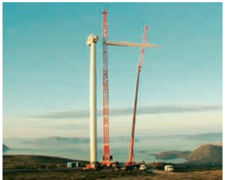
15. Juli 2002: Die erste N80 bei der Errichtung in Norwegen
