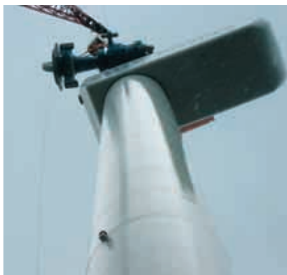
... anschließend wird der Triebstrang montiert.
