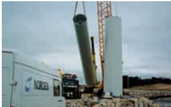
4 Das erste Turmsegment steht, das zweite folgt umgehend.
