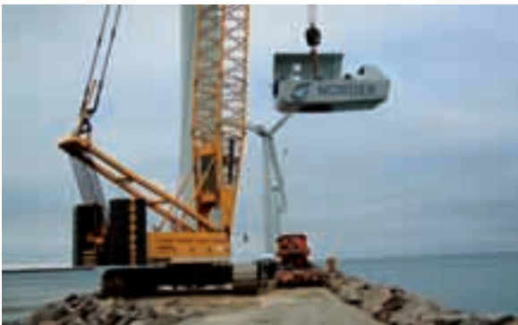
5 Der Kran hebt die Gondel auf den Turm. Auf den ersten Blick Routine – doch die schmale Pier erforderte, dass der Kran bei jeder Anlage zuvor demontiert wurde, um an die Errichtungsstelle zu gelangen.
