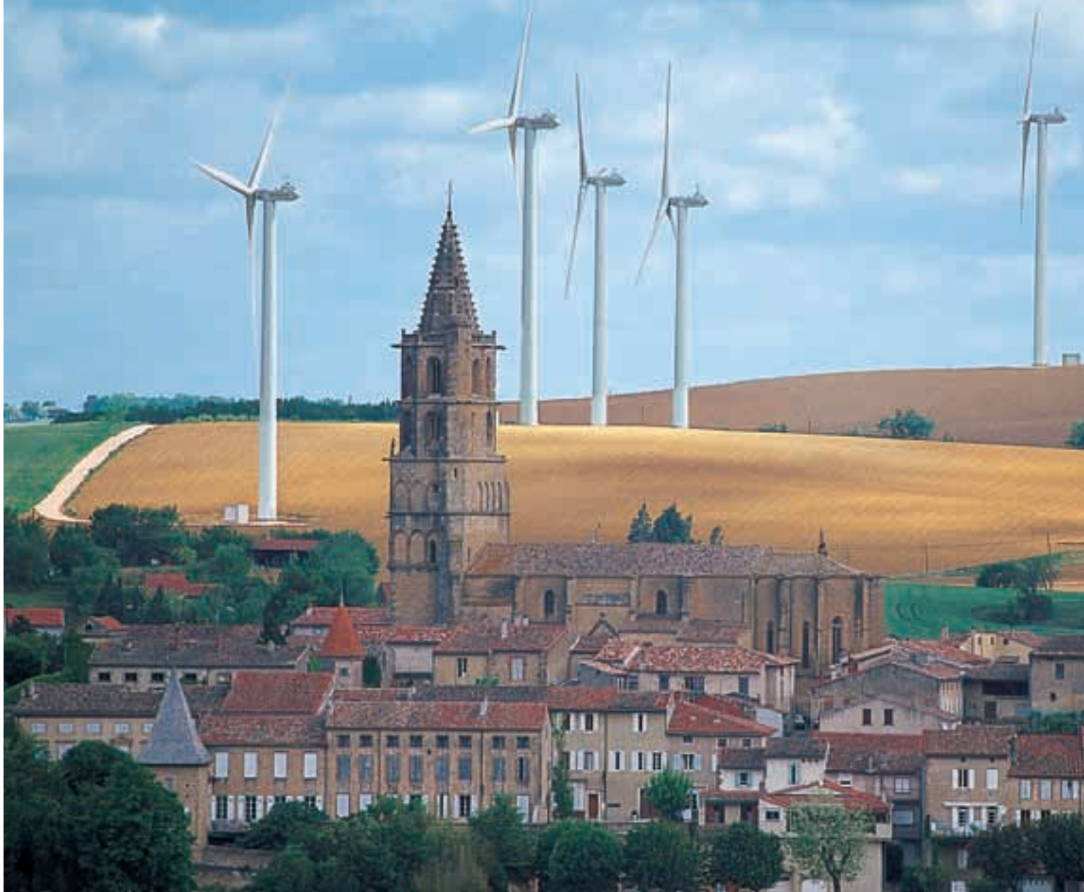
Windpark „Avignonet“ – 10 Anlagen vom Typ N50/800 kW ca. 50 Kilometer süd-östlich von Toulouse.
