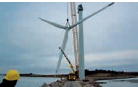
7 Der Rotor wird an die Gondel montiert.
