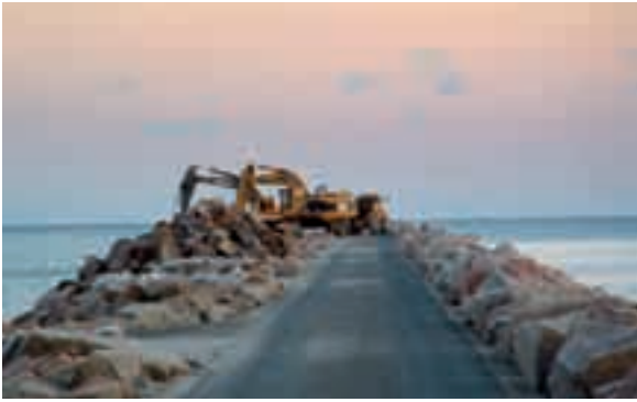
1 Die alten Anlagen und Fundamente wurden von der Pier entfernt, gleichzeitig wurde die Uferbefestigung für die größeren Nordex-Anlagen erweitert. Die Pfahlfundamente sind direkt auf dem Meeresgrund verankert, die Kabel in die Pier eingelassen.
