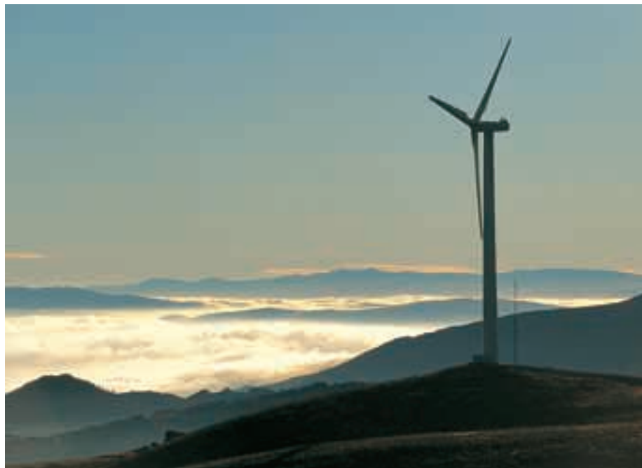
N60 im Windpark Cabeço Alto, Portugal.
