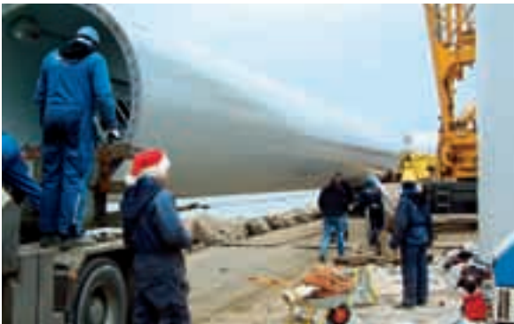
3 Das untere Turmsegment kurz vor der Errichtung.
